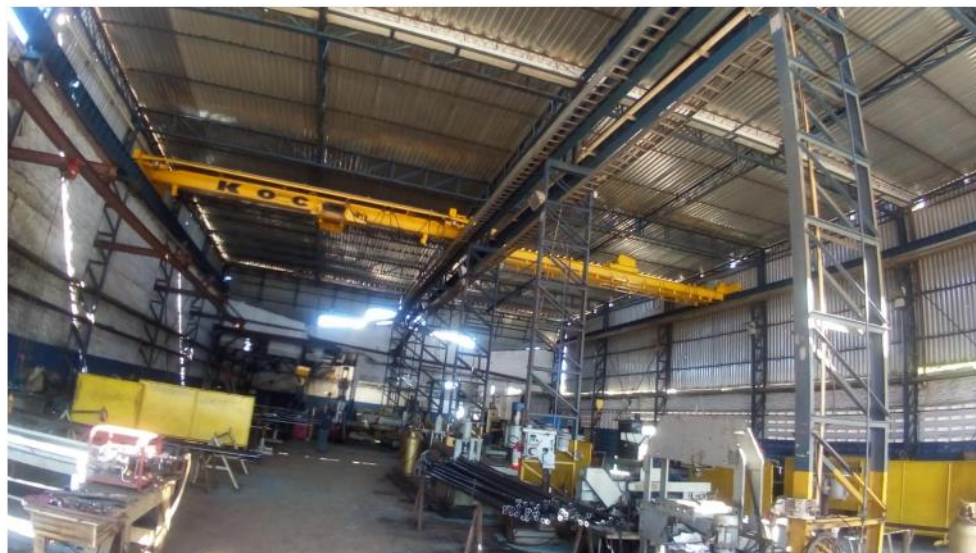
Galpão – 01 – Com Ponte Rolante de 10T
