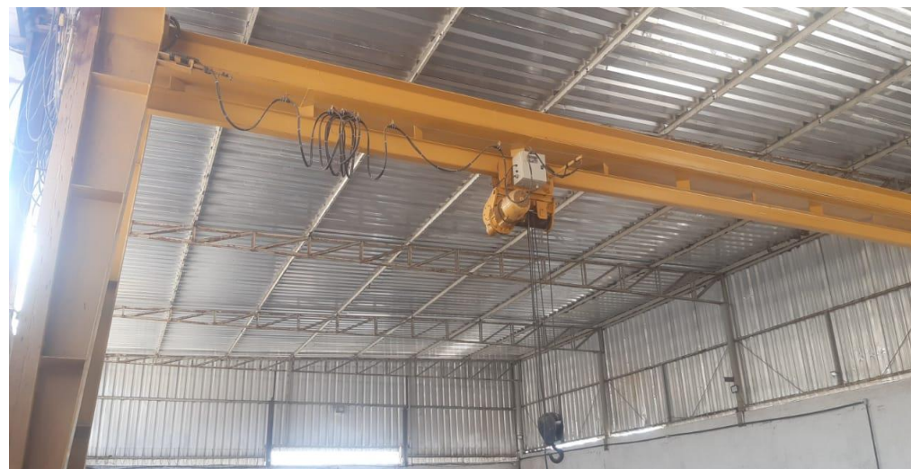
Galpão – 02 – Com Ponte Rolante de 10T
